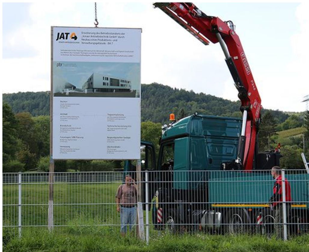
Bildunterschrift: Bauschild wird auf dem Baugelände platziert
